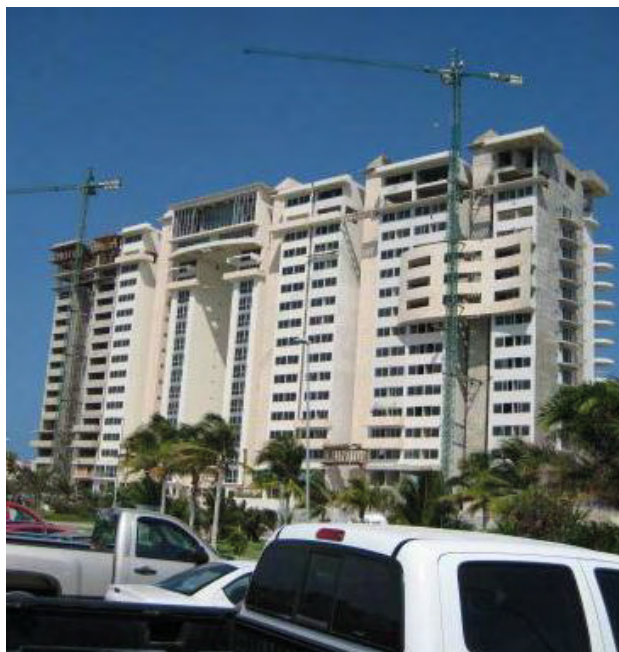
Figura 4. Edificio de 20 niveles Isola, Cancún, Q.Roo.
