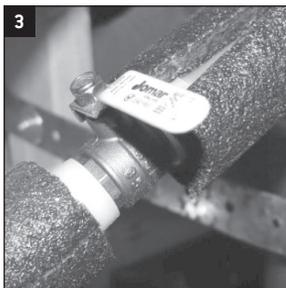
4. Installez la soupape FloodStop entre la conduite d'eau rigide provenant de la soupape manuelle d'eau froide et le chauffe-eau, de façon à ce que la flèche sur le côté de la soupape pointe vers le chauffe-eau (dans le sens du débit d'eau). **REMARQUE** : La soupape Floodstop doit être installée à moins de 0,6 m [2 pi] du chauffe-eau de manière à ce que le capteur de fuite puisse être posé à plat sur le plancher.
