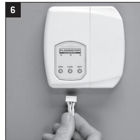
7. Prenez le câble court du panneau de commande et raccordez-les aux câbles de la soupape FloodStop (assurez-vous que les flèches sur chaque côté des prises sont bien alignées).
