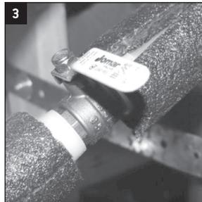
4. Instale la válvula FloodStop entre la tubería de agua rígida que sale de la válvula manual de agua fría y el calentador de agua, colocada de forma que la flecha del costado de la válvula apunte hacia el calentador de agua (en la dirección del flujo de agua). **NOTA:** La válvula FloodStop debe instalarse a menos de 2 pies del calentador de agua para que el sensor de fugas pueda apoyarse en el suelo.
