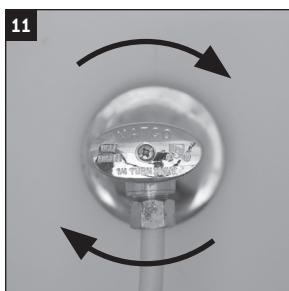
13. Ouvrez progressivement la soupape principale d'alimentation en eau.
