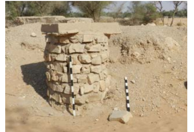
ج. فوهة بئر في بطن الوادي عند دخوله لبلدة العيينة، محمية بجدار من الحجارة بارتفاع متر ونصف المتر. c. A Stone-protected well in Wadi Hanifa with a height of 1.5m.
