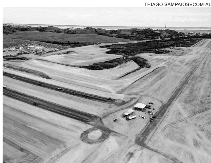
Pista de pouso, decolagens e toda terraplenagem estão quase prontas
